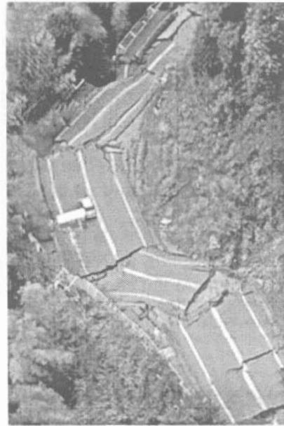
Hình 6.14 Một tuyến cao tốc ở Nagaoka, Tây Bắc Nhật Bản, bị cắt đứt sau trận động đất mạnh 6,8 độ Richter ngày 16-7-2007
